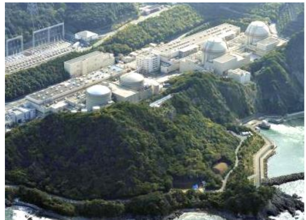
断層だらけの大飯原発3号機、4号機（奥の2基）
